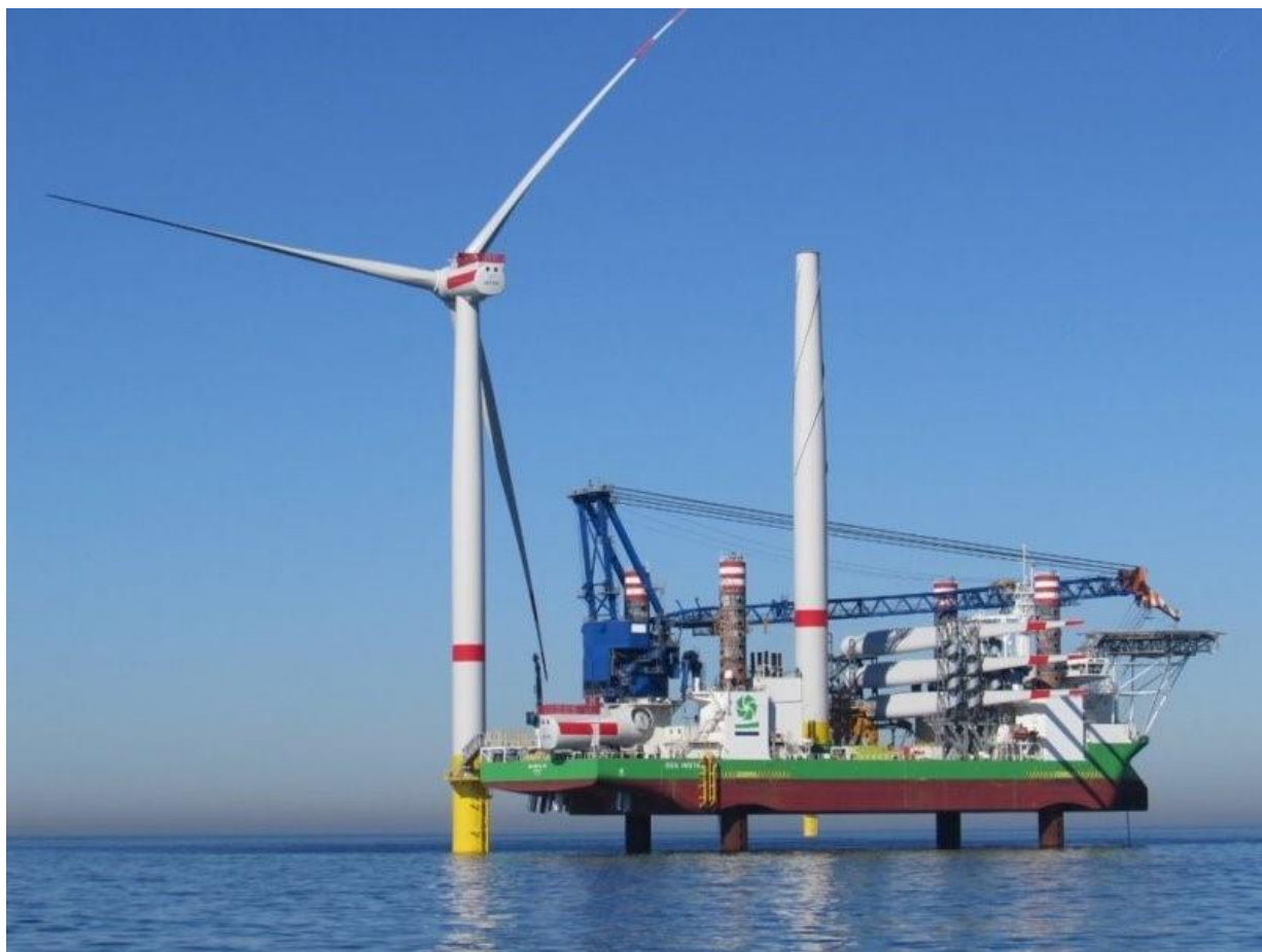
Rysunek 15. Montaż elektrowni wiatrowej z wykorzystaniem statków typu jack-up. Źródło: COWI
