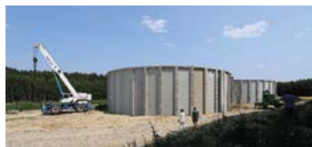
■ Fermentator budowany na potrzeby elektrociepłowni OZE
