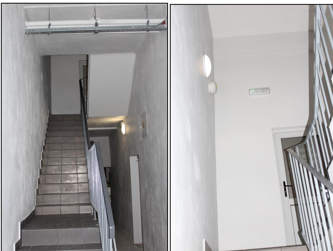
Fot. Remont klatki schodowej i korytarza
