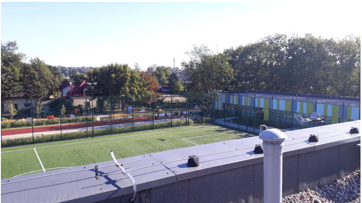
Rys. 3 Miejsce montażu SELMS PEM – Szkoła Podstawowa nr 10 w Pruszkowie – widok na stacje bazowe
