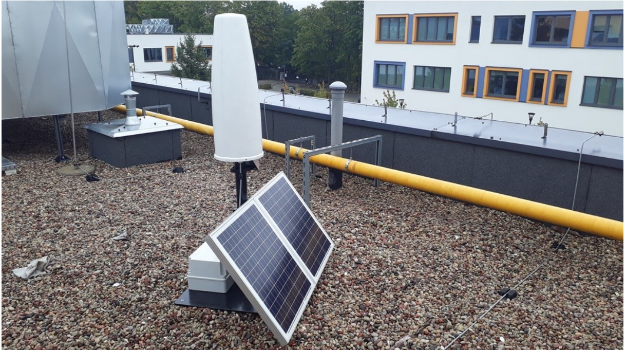
Rys. 2 Miejsce montażu SELMS PEM – dach Szkoły Podstawowej nr 10 w Pruszkowie
