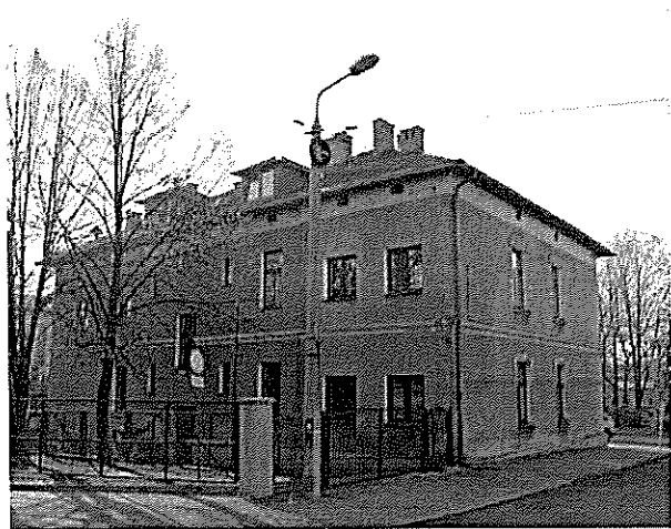
Widok - elewacja północno wschodnia
