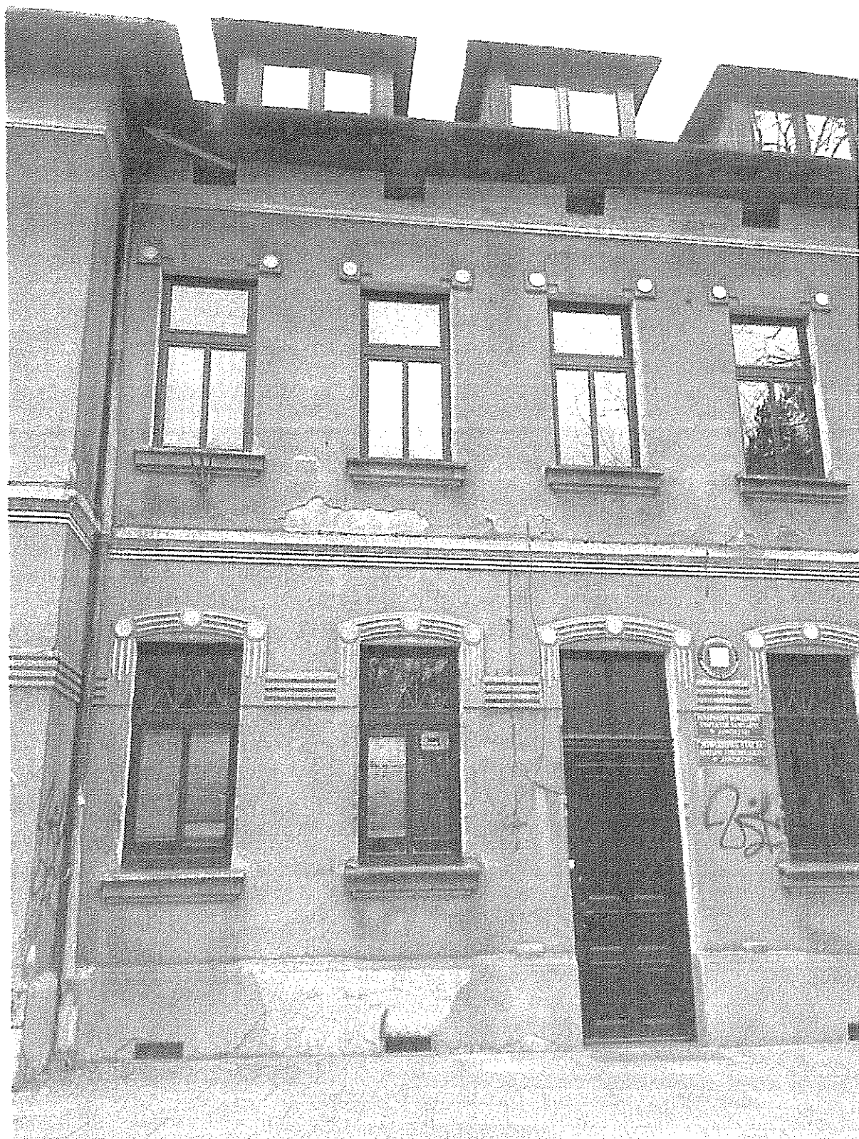
Ryc. 3. Jaworzno ul. Pocztowa 7 elewacja zachodnia fragment II. Strzałka wskazuje dogodne miejsce lęgowe dla jerzyków Apus apus (fot. budynku z dn. 23.04.2016 – S.Czyż)
