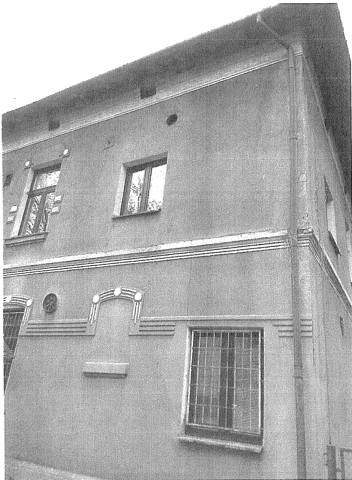
Ryc. 16. Jaworzno ul. Pocztowa 7 elewacja południowa fragment I (fot. budynku z dn. 23.04.2016 – S.Czyż)
