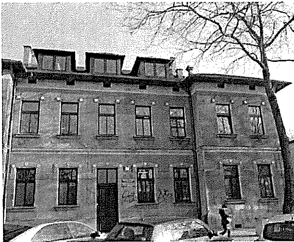
Widok - elewacja zachodnia (front)
