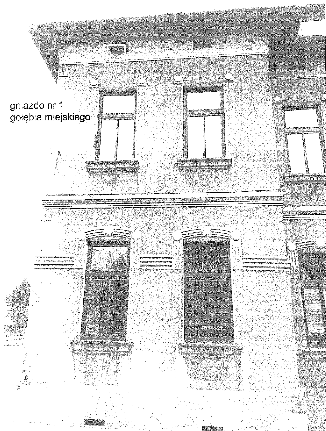
Ryc. 2. Jaworzno ul. Pocztowa 7 elewacja zachodnia fragment I. Widoczne czynne gniazdo gołębia miejskiego Columba livia f. urbana (fot. budynku z dn. 23.04.2016 – S.Czyż)
