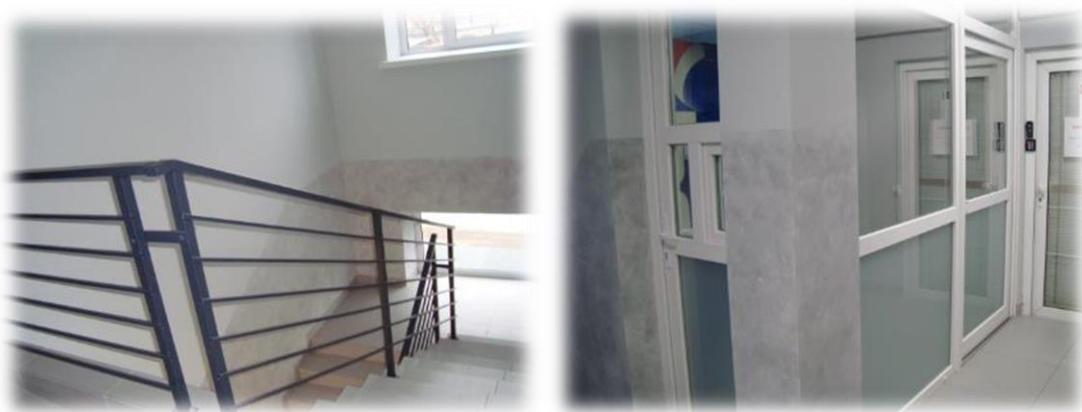
Klatka schodowa i pomieszczenie służby dyżurnej.
