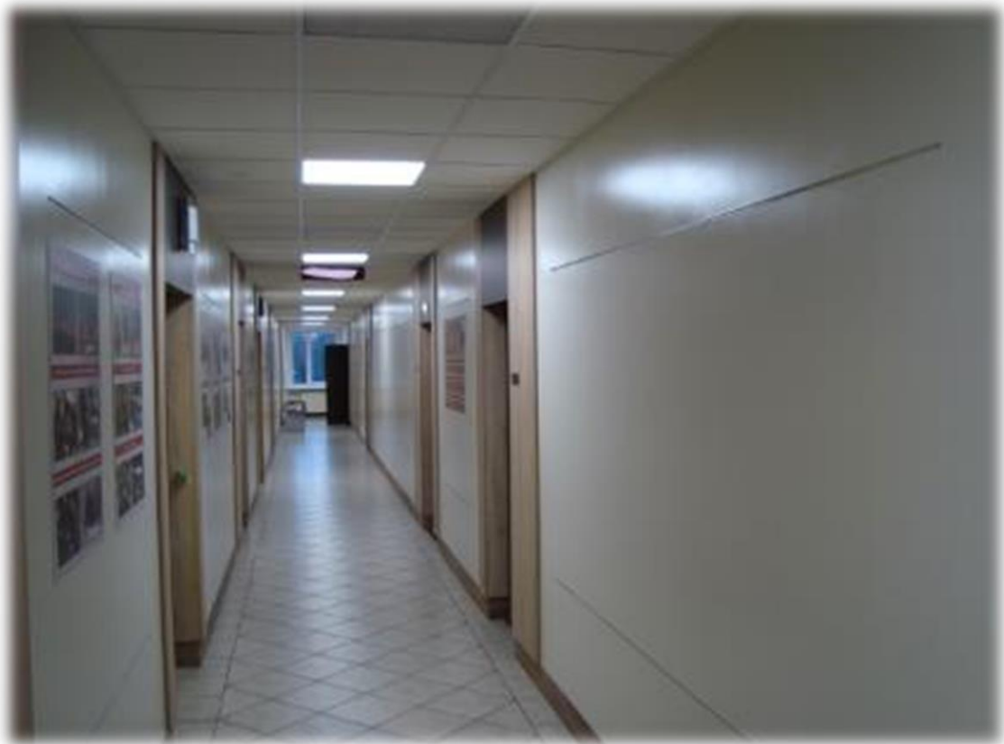
Odnowiony korytarz i drzwi ześlizgów wraz z zamontowaną automatyką.
