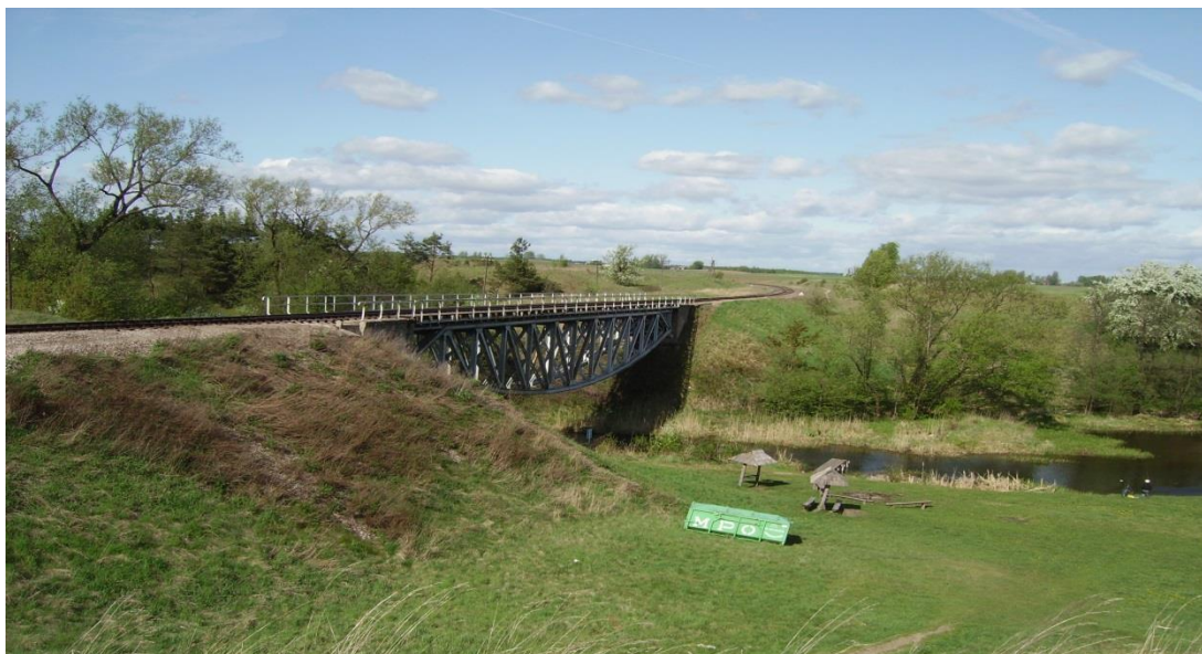
Most kolejowy w Raczkach (Fot. T. Hryciuk)
