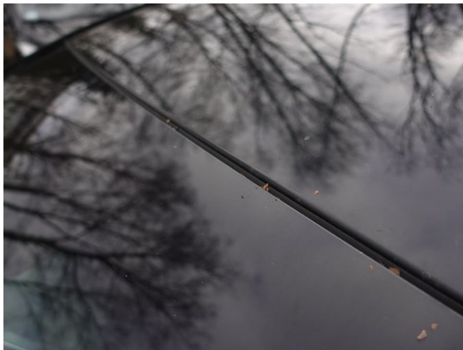
Poszycie przedniej części dachu
