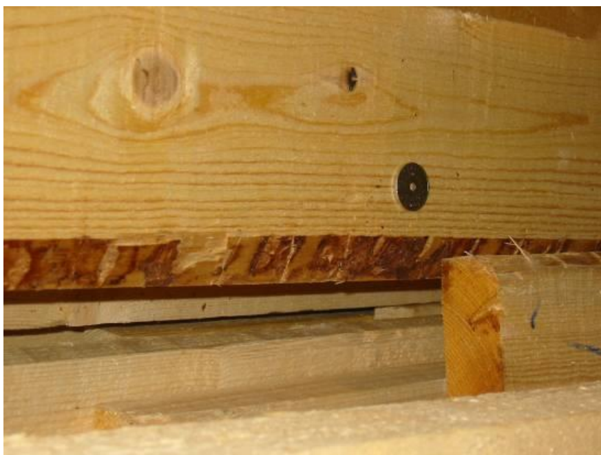
Zdjęcie 1 – Oflis na krawędzi deski nie podlega przepisom.
