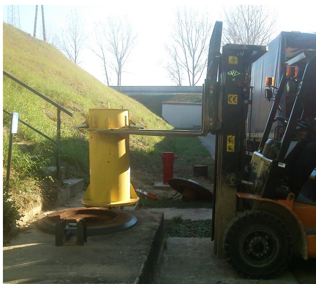
Rys. 8. Przeniesienie zużytych zamkniętych źródeł promieniotwórczych do komory przeznaczonej do składowania (źródło własne).
