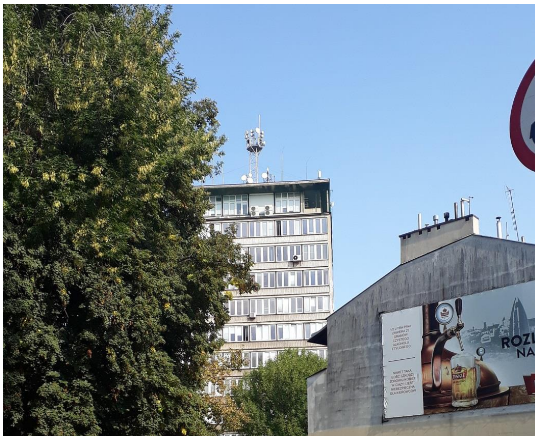
Rys. 3 Miejsce montażu pilotażowego SMS PEM – UM Rzeszów – widok z poziomu gruntu
