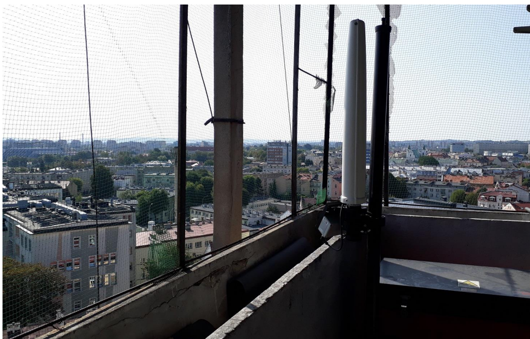
Rys. 2 Miejsce montażu pilotażowego SMS PEM – UM Rzeszów
