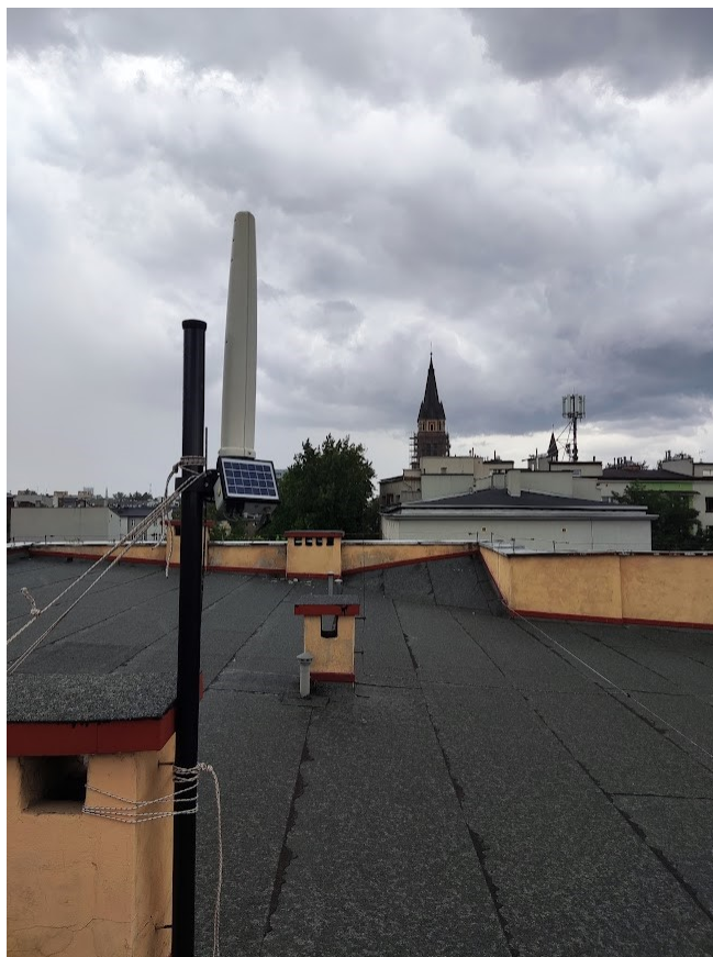
Rys. 2 Miejsce montażu SMS PEM – Szkoła Podstawowa nr 4 w Sosnowcu – widok na SBTK
