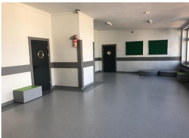
Zdjęcie 12. Ciąg komunikacyjny po generalnym remoncie w Publicznej Szkole Podstawowej w Brzostowej.
