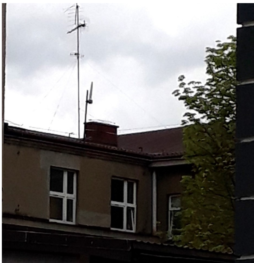
Rys. 2 Miejsce montażu SMS PEM – Szkoła Podstawowa nr 11 w Piotrkowie Trybunalskim – widok z poziomu gruntu
