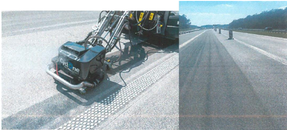
Uszorstnienie nawierzchni SMA LA na inwestycji S6
