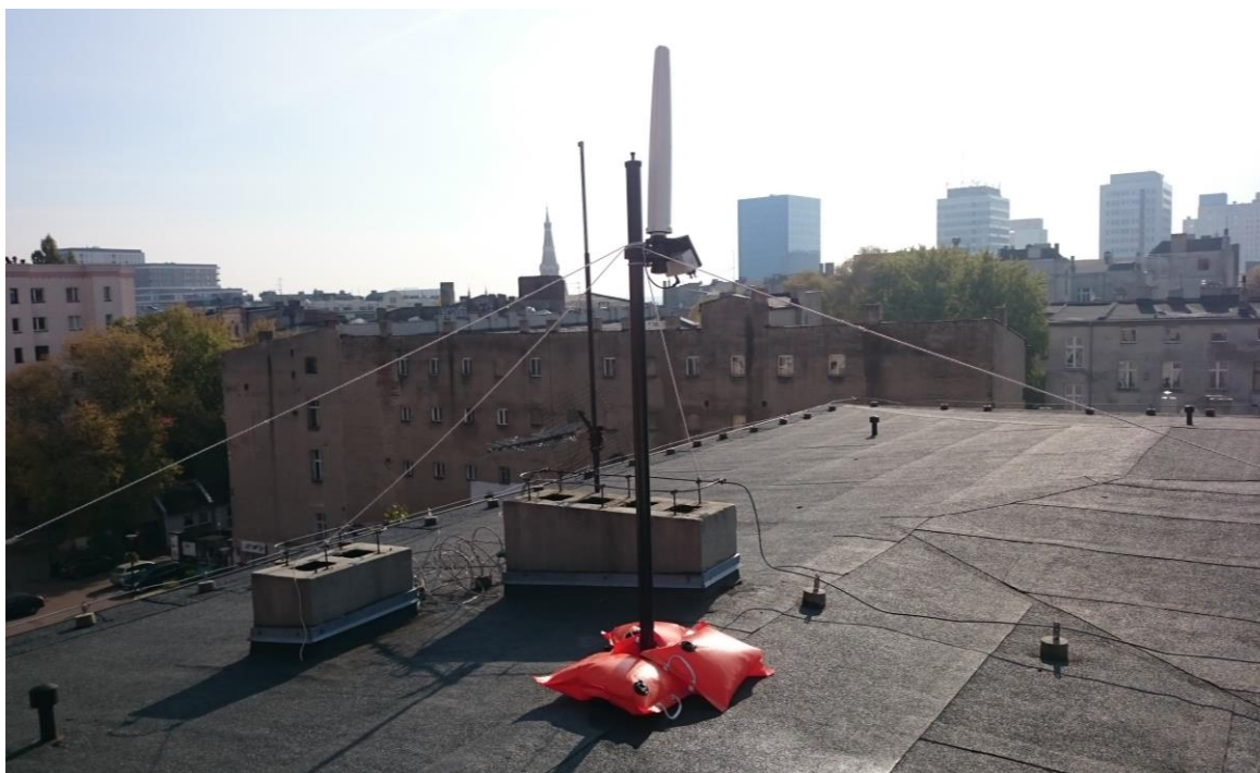
Rys. 4 Miejsce montażu pilotażowego SMS PEM – dach UM Łódź
