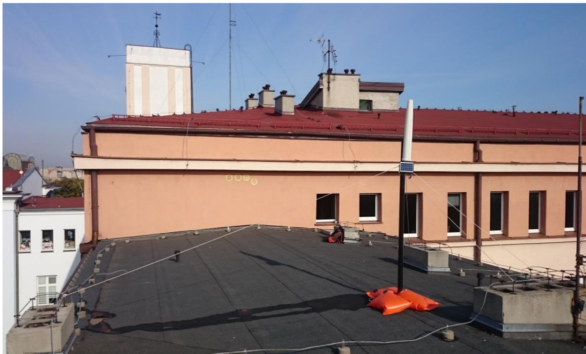
Rys. 3 Miejsce montażu pilotażowego SMS PEM – dach UM Łódź
