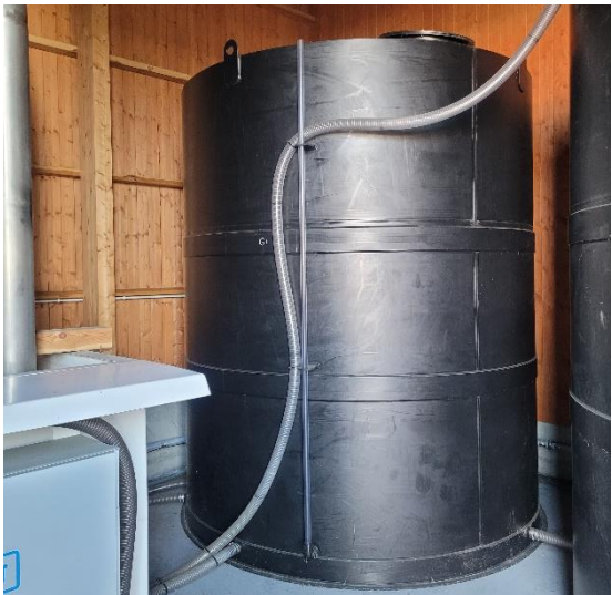
Fot. 1 i 2 Po lewej zbiornik do składowania roztworu chlorku sodu lub wapnia nazywanej powszechnie „solanką”, po prawej – magazyn materiałów do zapobiegania śliskości (chlorek wapnia składowany w workach typu „big bag”).
