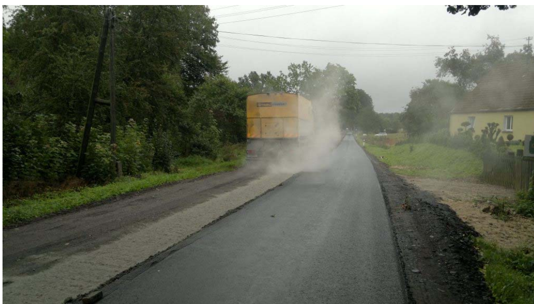
Rysunek 5.2. Dozowanie cementu na destruk bitumiczny
