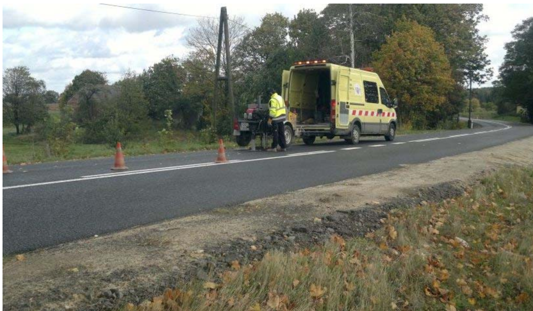
Rysunek 5.8. Pobieranie próbek z wykonanej nawierzchni.
