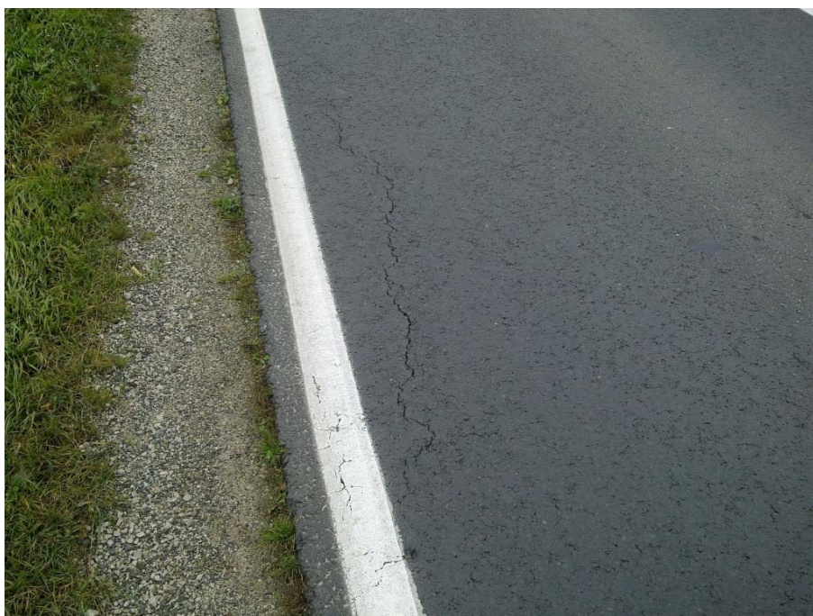
Rysunek 2.26. Obłamanie krawędzi
