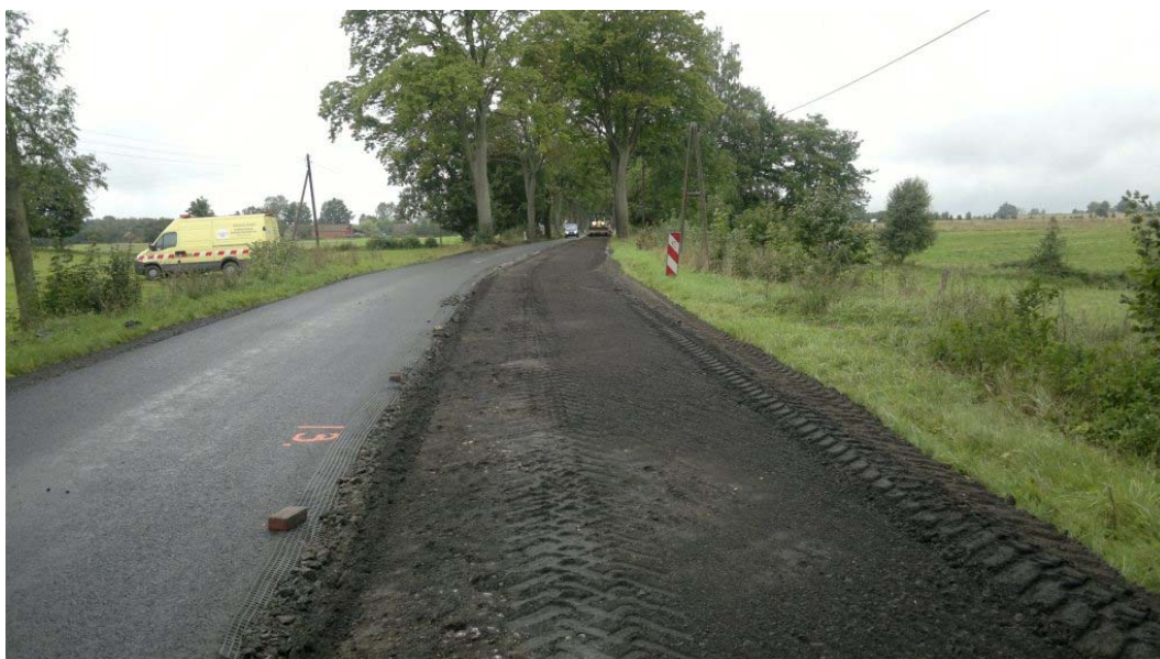
Rysunek 5.1. Rozłożona warstwa podbudowy z mieszanki MCE
