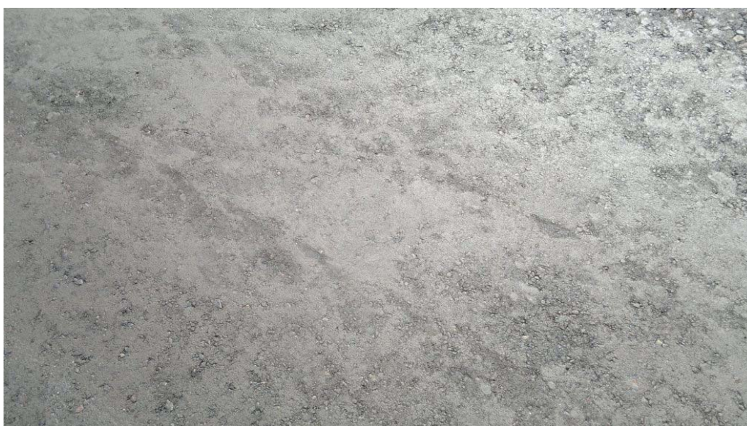
Rysunek 5.6. Zagęszczona warstwa podbudowy z mieszanki MCE
