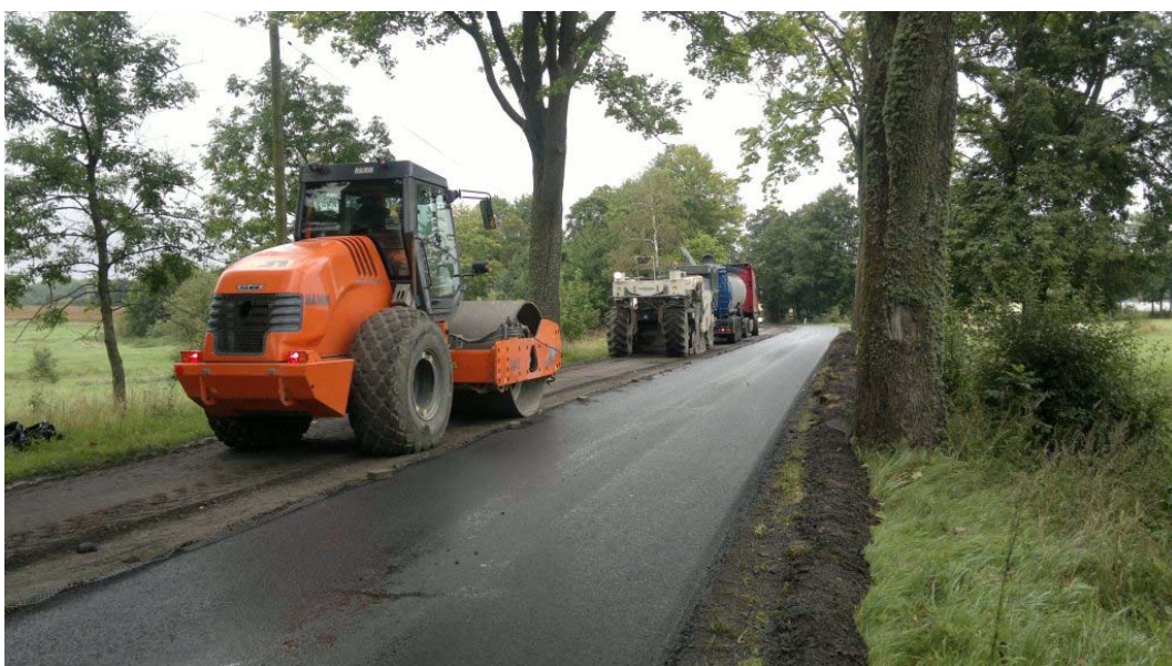
Rysunek 5.4. Wstępne zagęszczanie warstwy MCE
