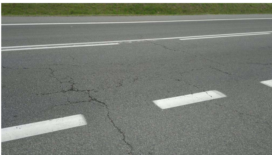
Rysunek 2.24. Spękania zmęczeniowe
