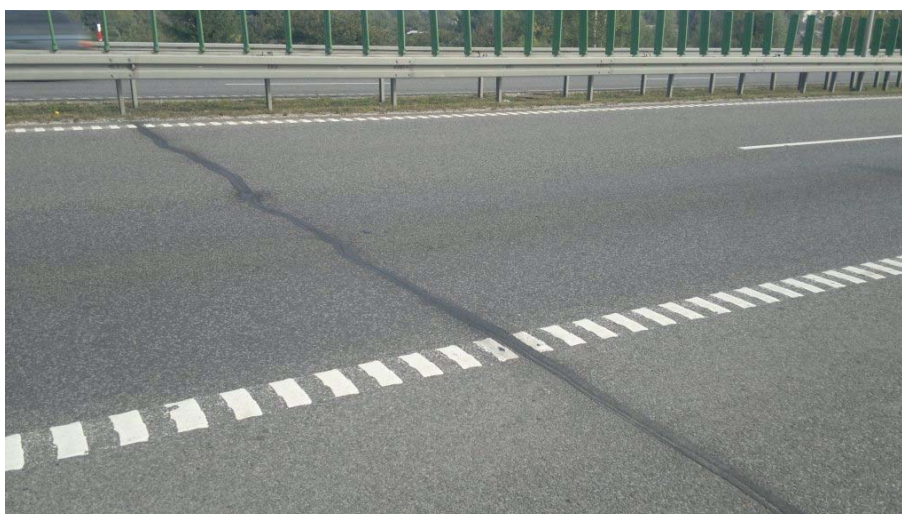
Rysunek 2.22. Spękanie poprzeczne zabezpieczone masą zalewową
