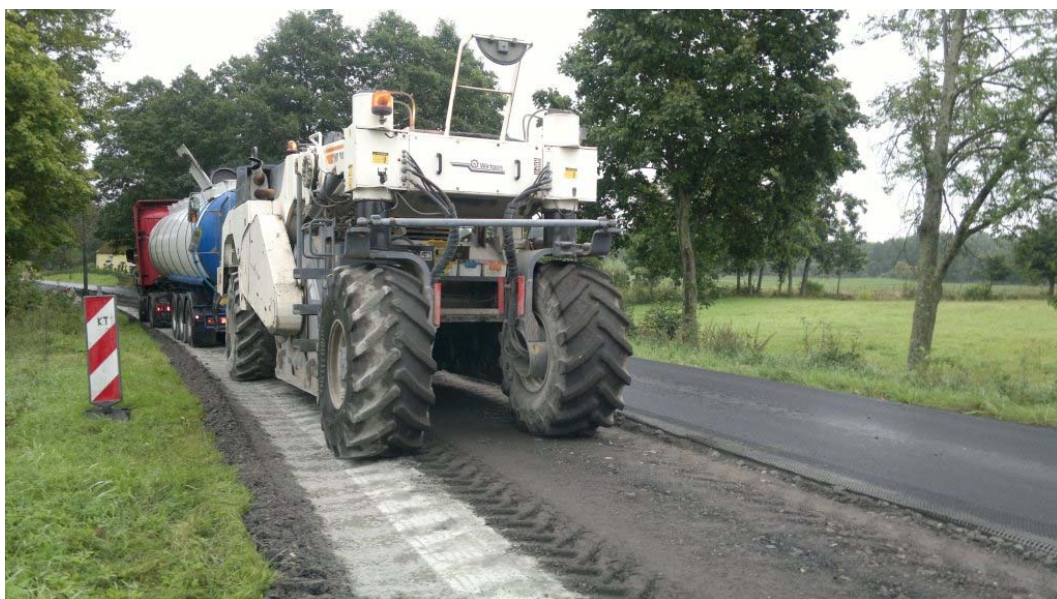
Rysunek 5.3. Dozowanie emulsji asfaltowej oraz mieszanie składników
