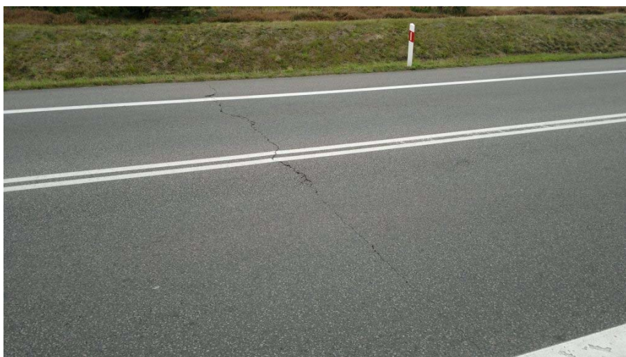
Rysunek 2.21. Typowe spękanie poprzeczne, niezabezpieczone masą zalewową
