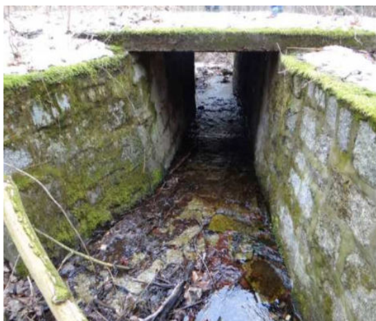
FOT. 1 WIDOK NA ISTNIEJĄCY MOST - WLOT
