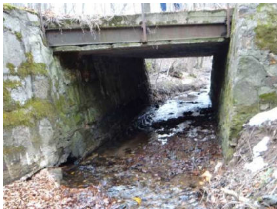
FOT. 4 WIDOK NA ISTNIEJĄCY MOST - WYLOT
