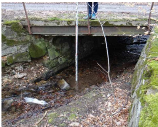
FOT. 3 WIDOK NA ISTNIEJĄCY MOST - WLOT
