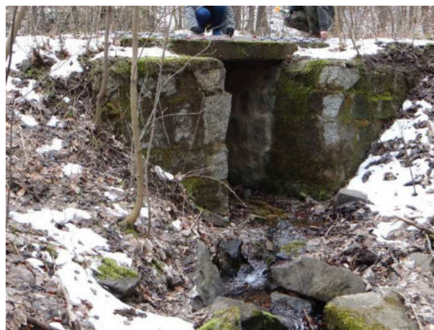
FOT. 2 WIDOK NA ISTNIEJĄCY MOST - WYLOT
