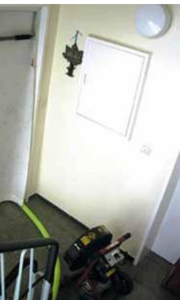
Pożar w mieszkaniu w budynku wielopiętrowym w Heilbronn. Pomieszczenie i przedpokój zniszczone przez ciepło i dym. Klatka schodowa była skutecznie broniona dzięki przenośnemu urządzeniu blokującemu
