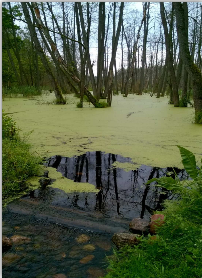
Próg piętrzący na rzece Osa
