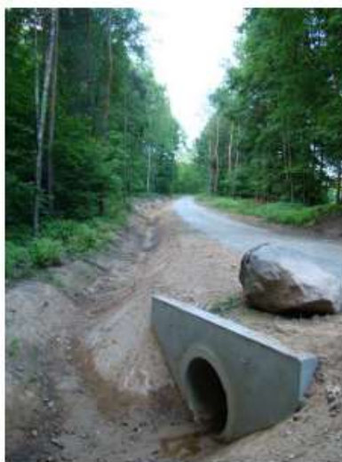
Zdjęcie nr 19. Budowa drogi leśnej przeciwpożarowej w leśnictwie Garwól, rok 2013. (fot. P. Goląb)
