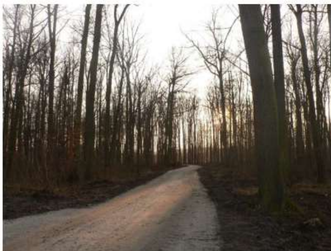
Zdjęcie nr 23. Remont drogi leśnej w leśnictwie Tarchalice, rok 2013. (fot. P. Goląb)
