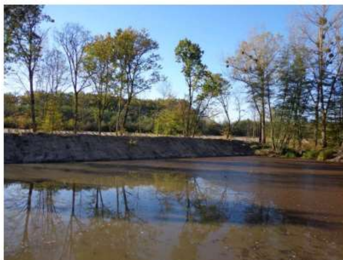
Zdjęcie nr 34. Modernizacja deszczowni i zbiornika retencyjnego na szkółce leśnej w Tarchalicach, rok 2014. (fot. P. Gołąb)
