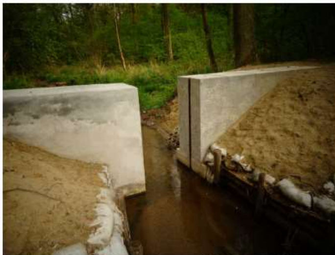
Zdjęcie nr 28. Modernizacja przepustu w leśnictwie Stryjno, rok 2013. (fot. P. Gołqb)
