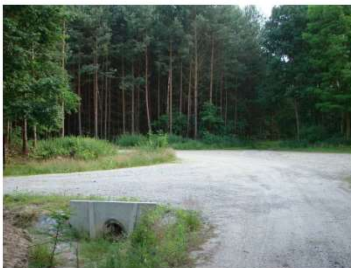
Zdjęcie nr 20. Łącznik dróg przeciwpożarowych w leśnictwie Krzelów (efekt końcowy budowy drogi leśnej przeciwpożarowej w leśnictwie Krzelów i leśnictwie Wińsko), rok 2011. (fot. P. Gołąb)
