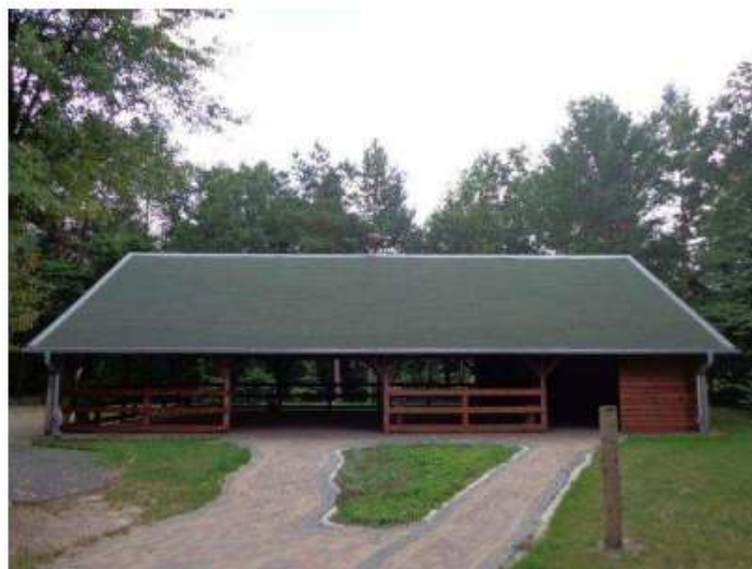
Zdjęcie nr 17. Budowa wiaty edukacyjnej na terenie szkółki leśnej w Tarchalicach, rok 2010. (fot. P. Gołąb)
