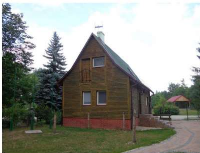
Zdjęcie nr 18. Modernizacja budynku edukacji przyrodniczo-leśnej w Tarchalicach, rok 2011. (fot. P. Goląb)
