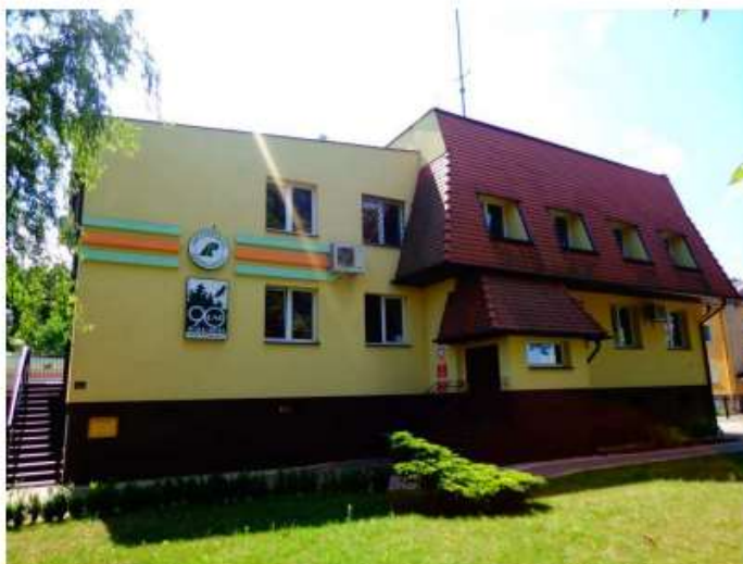
Zdjęcie nr 29. Remont inwestycyjny budynku biurowca nadleśnictwa, rok 2013. (fot. P. Gołqb)
