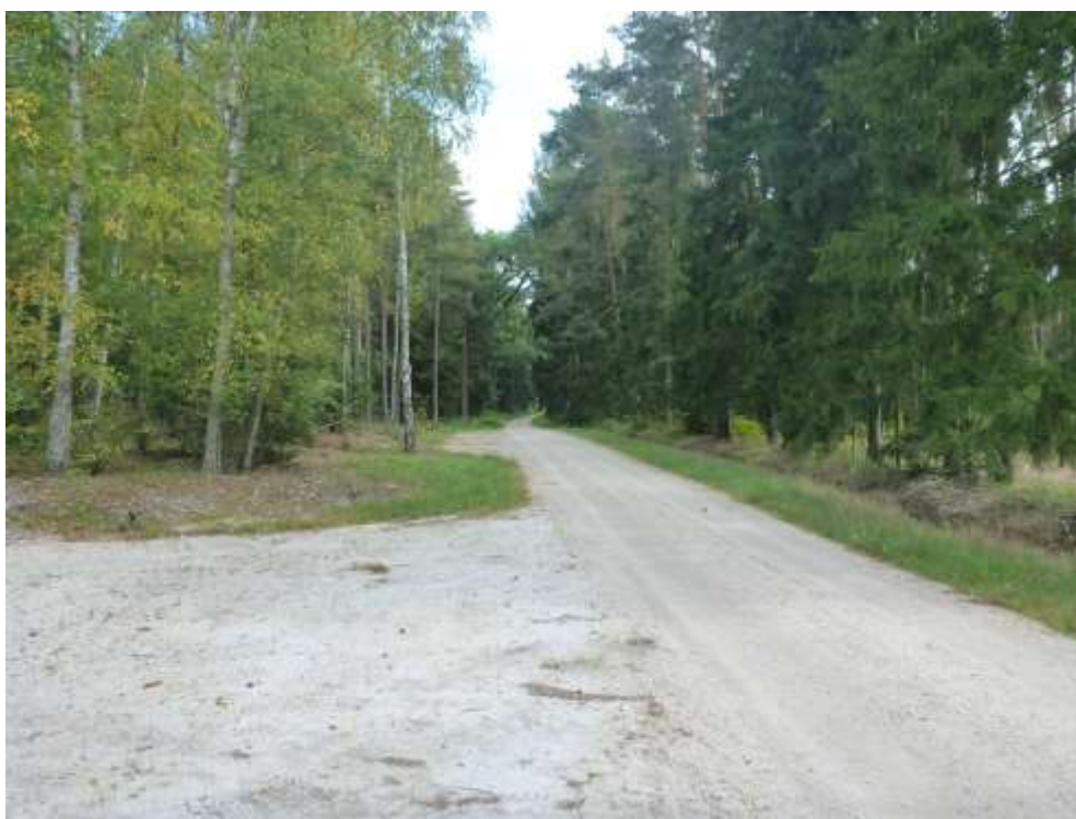
Zdjęcie 16. NOWOWYBUDOWANA DROGA W OBRĘBIE DĘBNO. (FOTO J. LISZCZYK)
