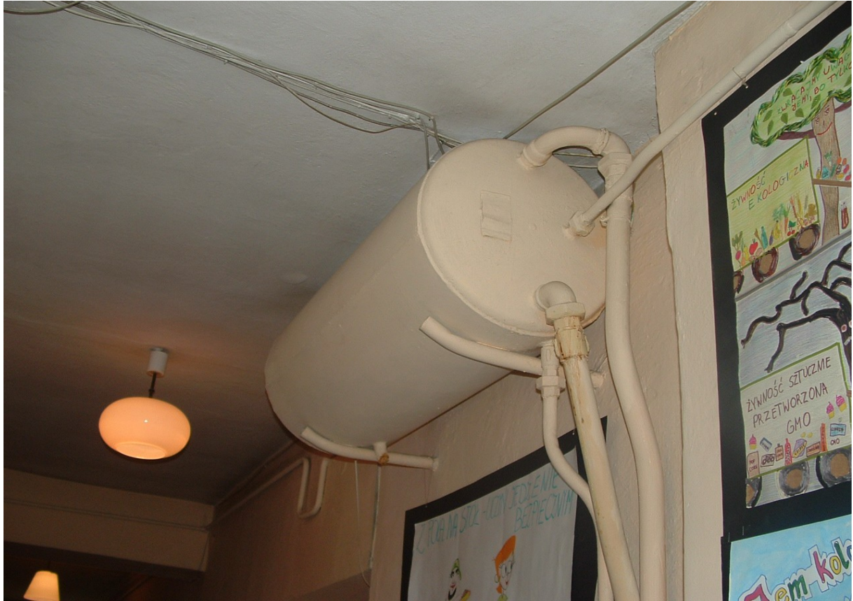
Fot. Nr 16 widoczne przecieki instalacji c.o.
