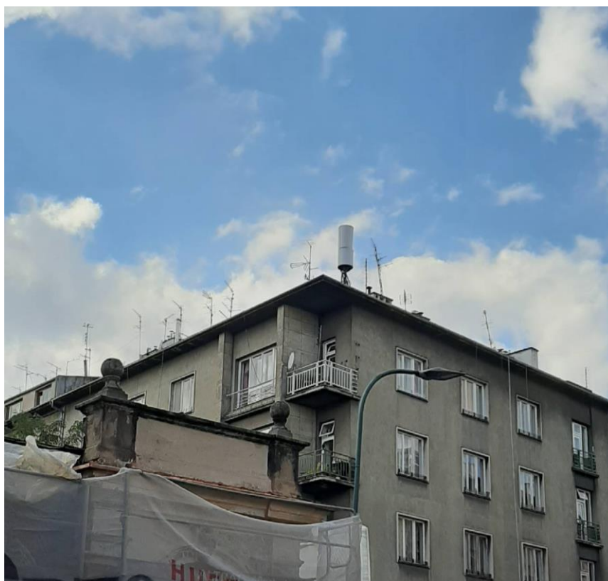
Fot. 1: Widok anten stacji bazowej ID: KRA0009_A, zlokalizowanej pod adresem: ul. Batorego 9, 31-135 Kraków
