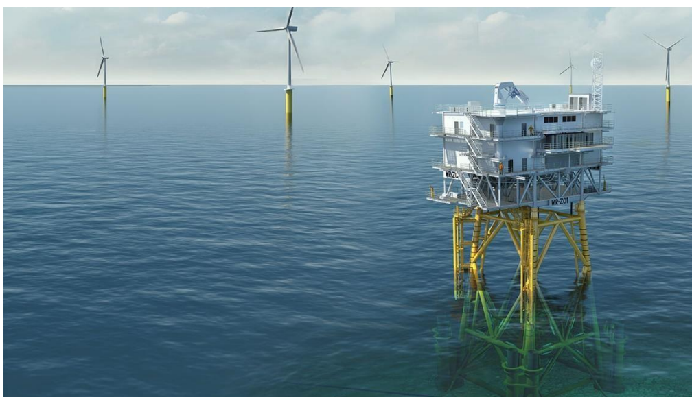
Il. 9 Szkic przedstawiający stację elektroenergetyczną morskiej farmy wiatrowej, posadowioną na fundamencie osadzonym w dnie (ilustracja: Ramboll).
