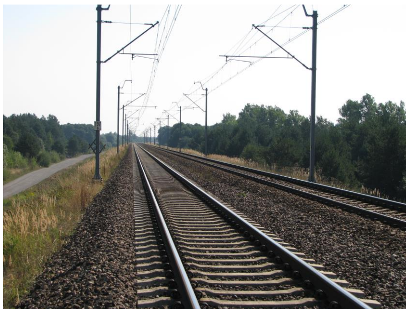
Fot. 3. Dżibice, RB1. Linia kolejowa nr 4 w kierunku Grodziska Mazowieckiego
