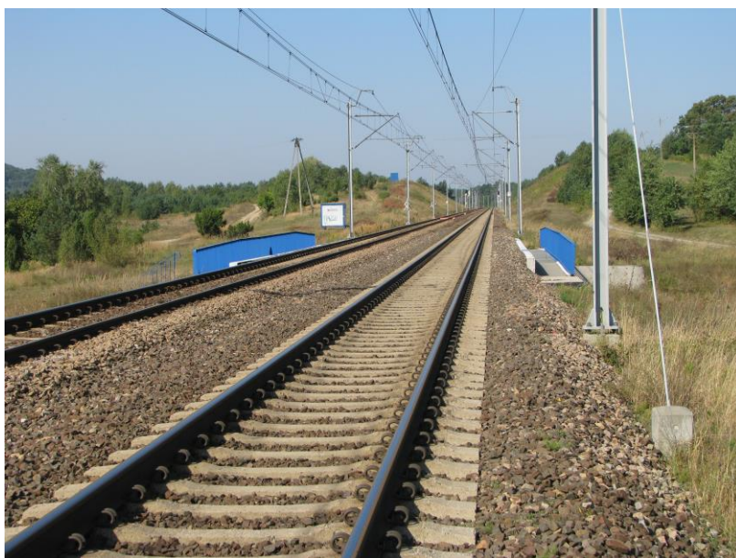
Fot. 2. Dzibice, RB1. Linia kolejowa nr 4 w kierunku Zawiercia
