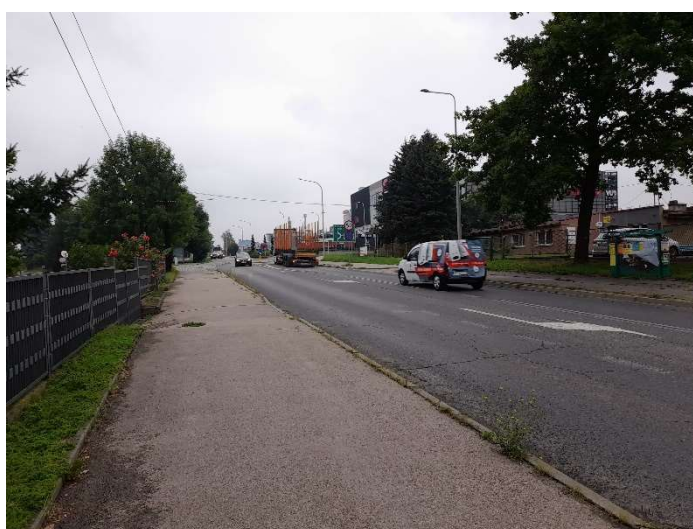
Fot. 12. Czechowice-Dziedzice, RB4. Badany odcinek ul. Legionów w kierunku skrzyżowania z ul. Paderewskiego.
