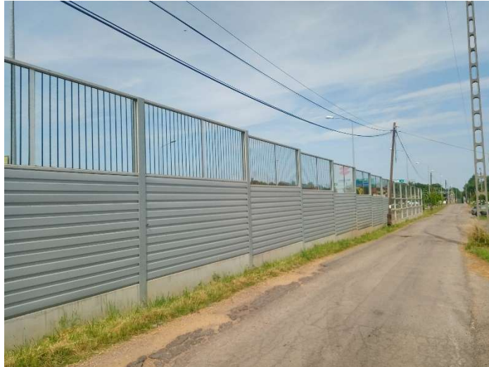
Fot. 2. Czechowice-Dziedzice, RB1. Badany odcinek drogi krajowej nr 1, widok od ul. Krętej.
