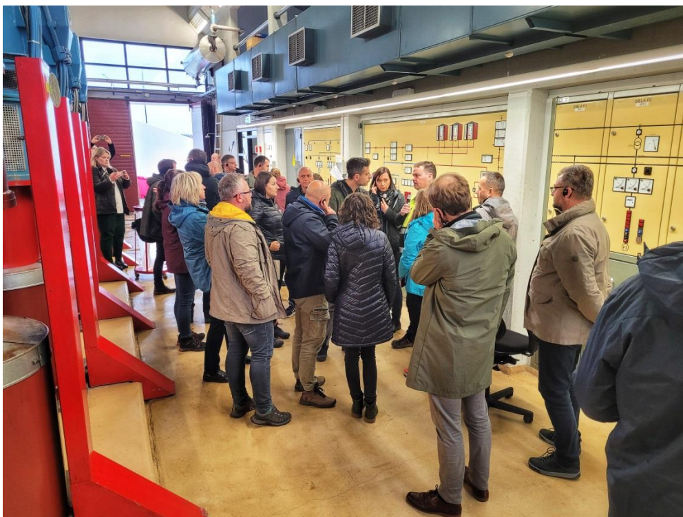
Wizyta w jednej z ciepłowni geotermalnych w rejonie Reykjavíku (fot. A. Kasztelewicz)
