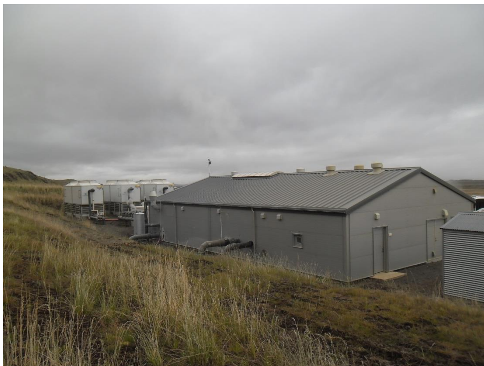
Widok ogólny geotermalnej instalacji kogeneracyjnej (ORC) we Fludir (fot. B. Kępińska)
