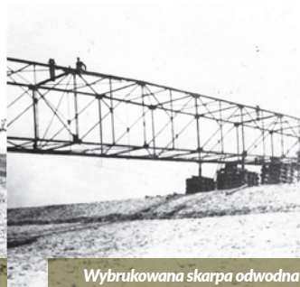
Brukowanie skarpy odwodnej
