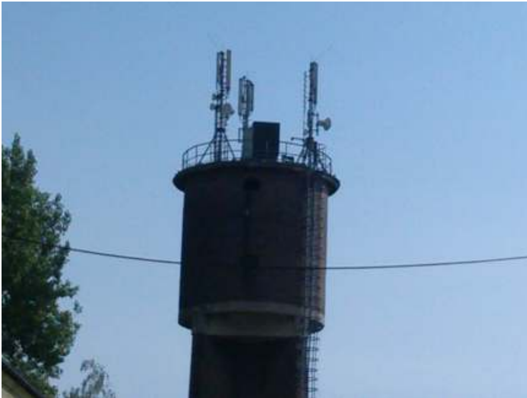
Fot. 3. Instalacje radiokomunikacyjne na wieży wodnej
