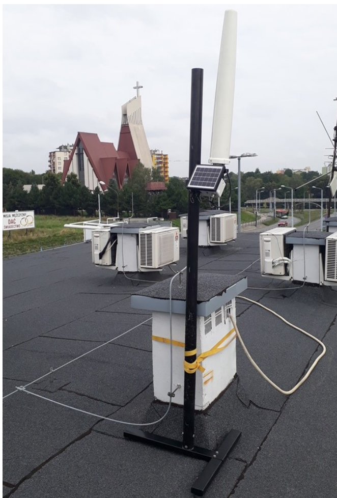
Rys. 2 Miejsce montażu SMS PEM – MOSiR „Bystrzyca” w Lublinie
