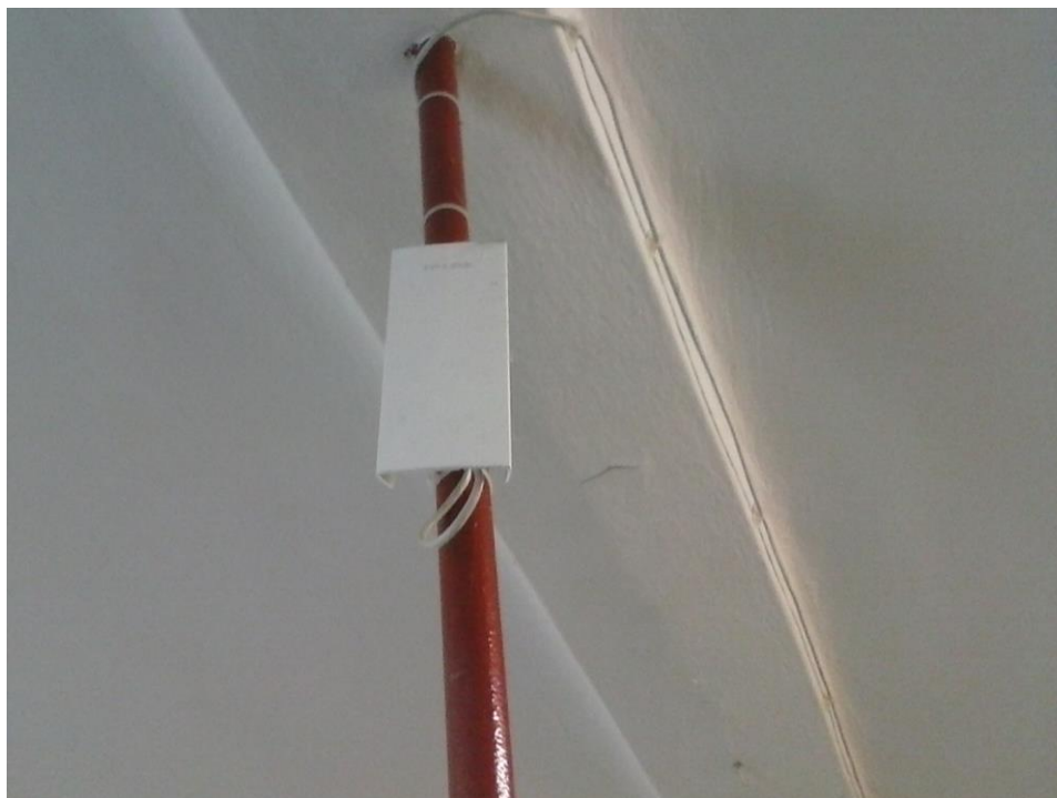
Fot. 1: Zdjęcie punktu dostępowego model CPE210
