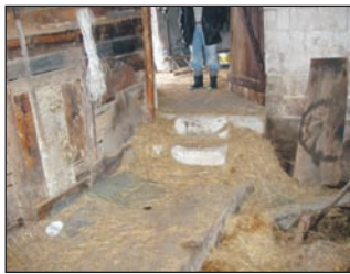
Niewłaściwa konstrukcja, zły stan techniczny schodów, brak poręczy i balagan (fot. OR Poznań, OR Opole i OR Lublin)
