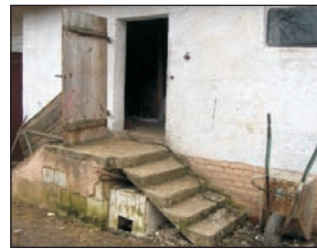
Niewłaściwa konstrukcja, zły stan techniczny schodów, brak poręczy i balagan (fot. OR Poznań, OR Opole i OR Lublin)
