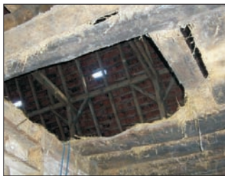
Brak zabezpieczeń otworów zrzutowych i zły stan techniczny budynków (fot. OR Lublin i OR Wrocław)
