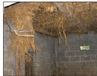
Brak zabezpieczeń otworów zrzutowych i zły stan techniczny budynków (fot. OR Lublin i OR Wrocław)
