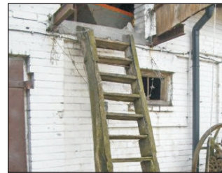
Niewłaściwa konstrukcja i zły stan techniczny drabin (fot. OR Koszalin, OR Kraków i OR Warszawa)
