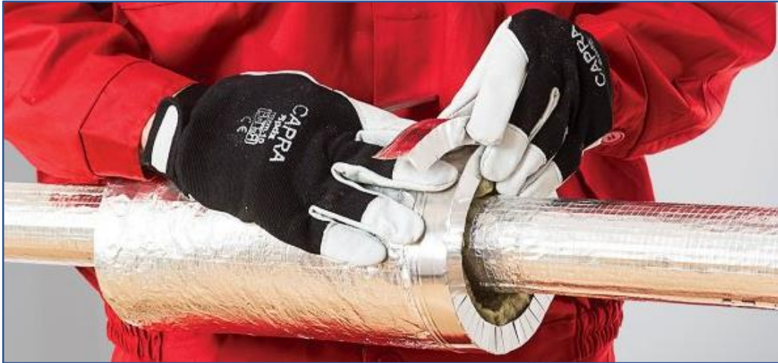
fot. 3 centrum izolacji: zabezpieczenie zakończenia izolacji mankietem aluminiowym
