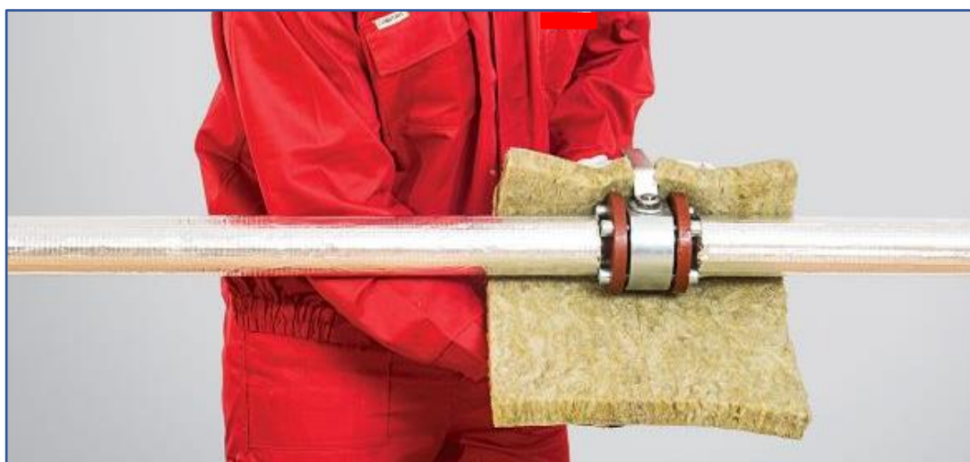
fot. 2 centrum izolacji: zabezpieczenie zaworu warstwą izolacji
