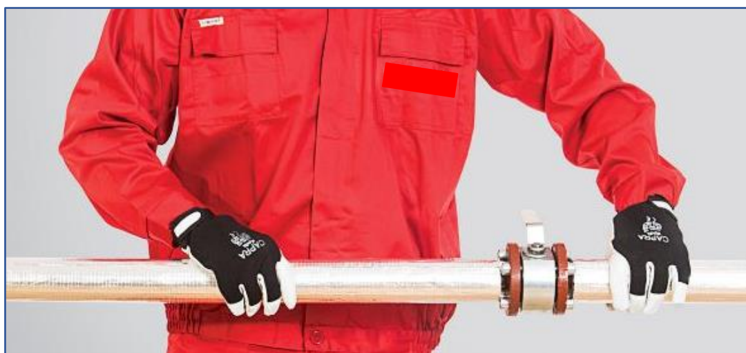
fot. 1 centrum izolacji: zawór
