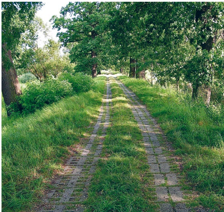
Ryc. 4. Fragment wału przeciwpowodziowego w okolicach planowanego polderu Lipki-Oława (fot. J. Krajewski)
