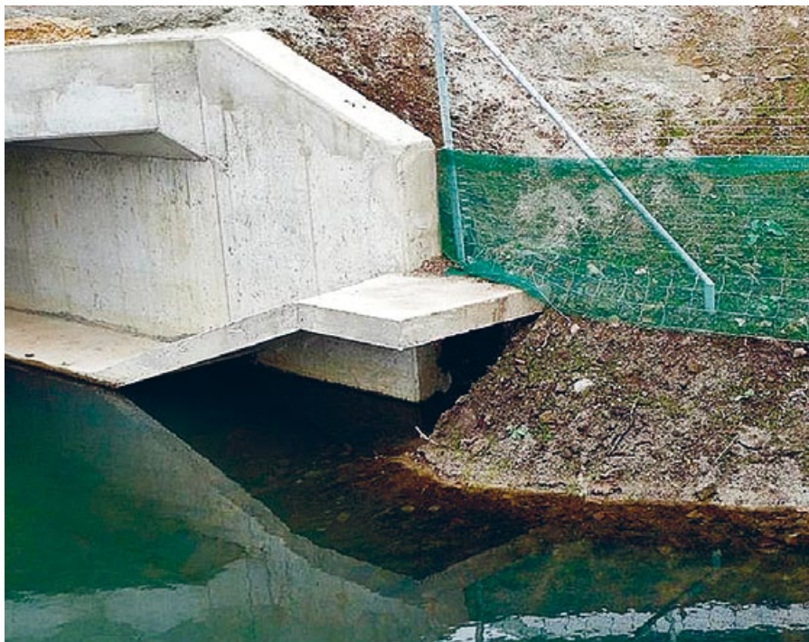
Ryc. 5. Błędnie wykonane przejście dla zwierząt – brak dogodnego dojścia do wiszącej półki (fot. K. Okrański)
