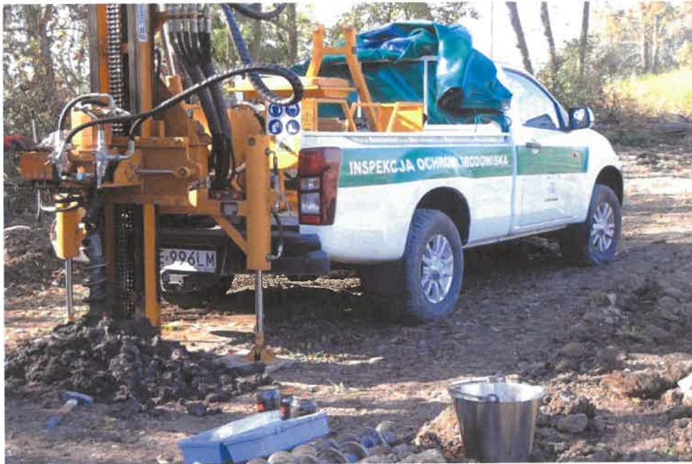
Wykonywanie odwiertów wiertnicą mechaniczną w m. Żeromin Drugi (gm. Gzy)
