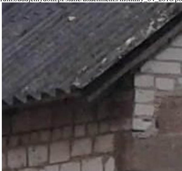
zdjęcie detalu ukazujące część eternitu na dachu
