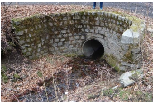
FOT.5 WIDOK NA WLOT PRZEPUSTU
