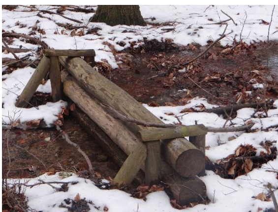
Przykładowy deflektor spowalniający odpływ
