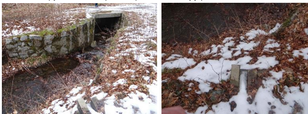
FOT. 4 WIDOK NA WLOT PRZEPUSTU WRAZ Z MUREM OPOROWYM ORAZ WODOSPUST
