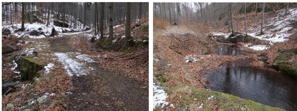
FOT.6 WIDOK NA ISTNIEJĄCY PRZEPUST ORAZ POWSTAŁE ROZLEWISKO
