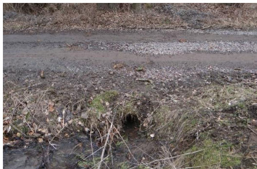
FOT.7 WIDOK NA ISTNIEJĄCY PRZEPUST
