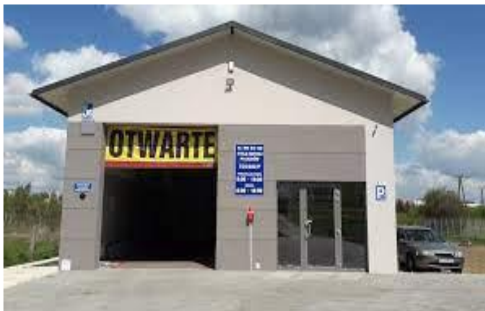
Fot. 2 Budynek usługowy - Podstawowa Stacja Kontroli Pojazdów zlokalizowana Brody,
