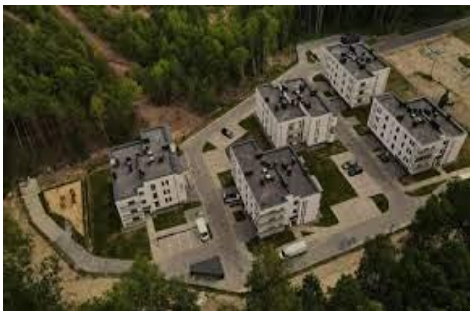
Fot. 4 Pięć budynków mieszkalnych wielorodzinnych wraz z instalacjami wewnętrznymi oraz 44 miejscami postojowymi przy ul. Kopalnianej w Starachowicach.
