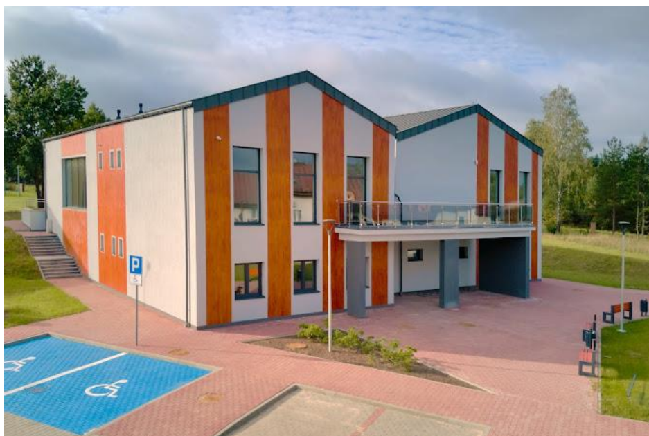
Fot. 1 - Centrum Edukacji Społecznej i Profilaktyki Zdrowotnej w miejscowości Krynki, ul. Szkolna, gm. Brody.
