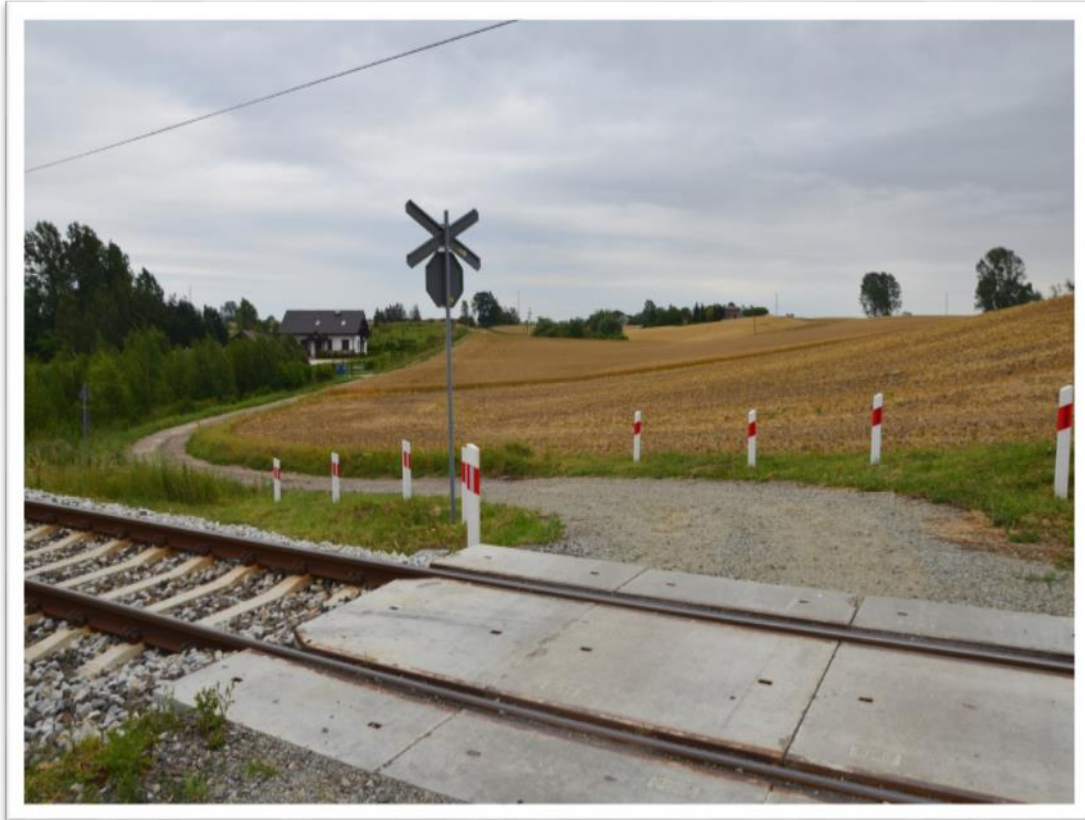
Ukształtowanie drogi dojazdowej z prawej strony przejazdu w kierunku jazdy pociągu.
