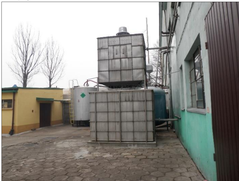
Ryc. 7. Zbiornik wody wraz z chłodnią wentylatorową wód chłodniczych, Wróblik Szlachecki, 2016-02-29 (źródło: [7])
