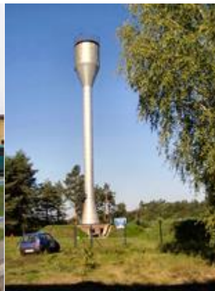
Ujęcie wody w Brzeziu Pomorskim https://www.supekom.pl/wp-content/uploads/2015/05/wodociagi_brzezie1.jpg
