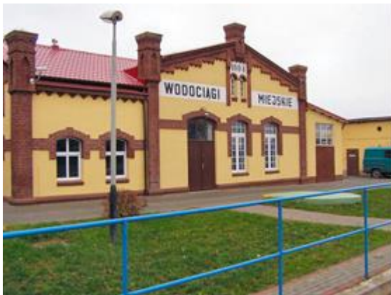
Stacja Uzdatniania wody w Sulechowie https://www.supekom.pl/wp-content/uploads/2015/05/wodociagi_sul2.jpg
