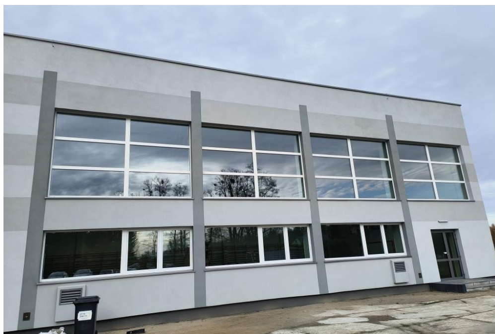
Ryc. Sala gimnastyczna przy Szkole Podstawowej w Kęszycach
