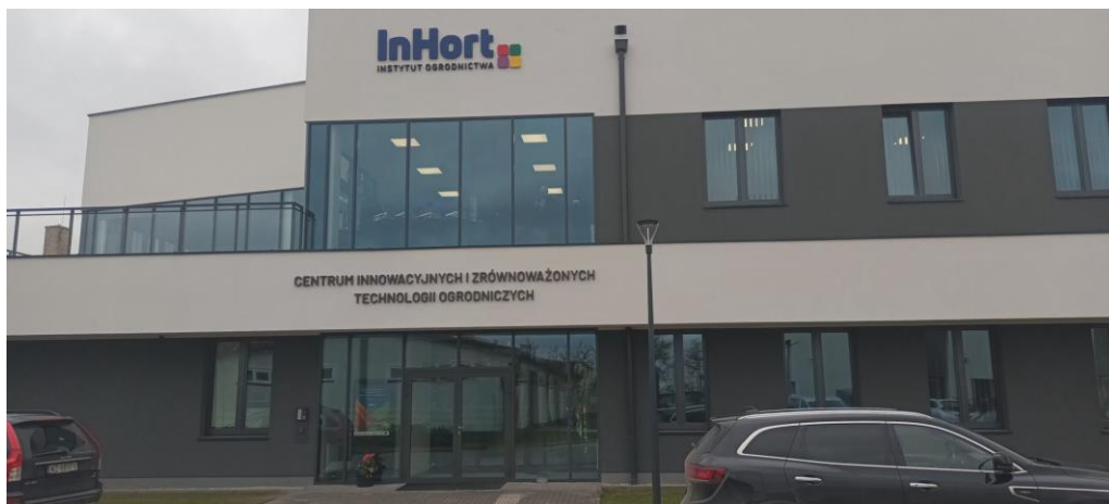
Ryc. Budynek Centrum Innowacyjnych i Zrównoważonych Technologii Ogrodniczych Źródło: https://radiolodz.pl/wp-content/uploads/2024/02/20240206_135108-scaled.jpg
