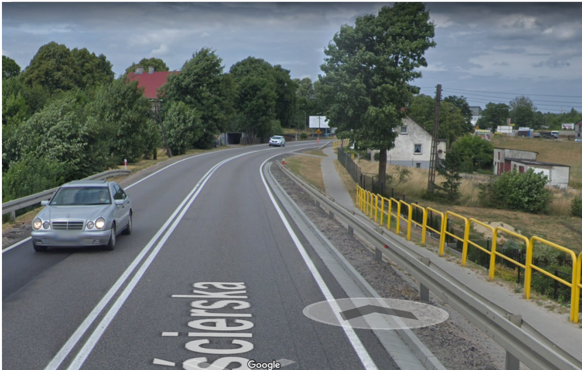
Fot. 4. Końcowy odcinek DK 20 odbjęty niniejszym zamówieniem.
