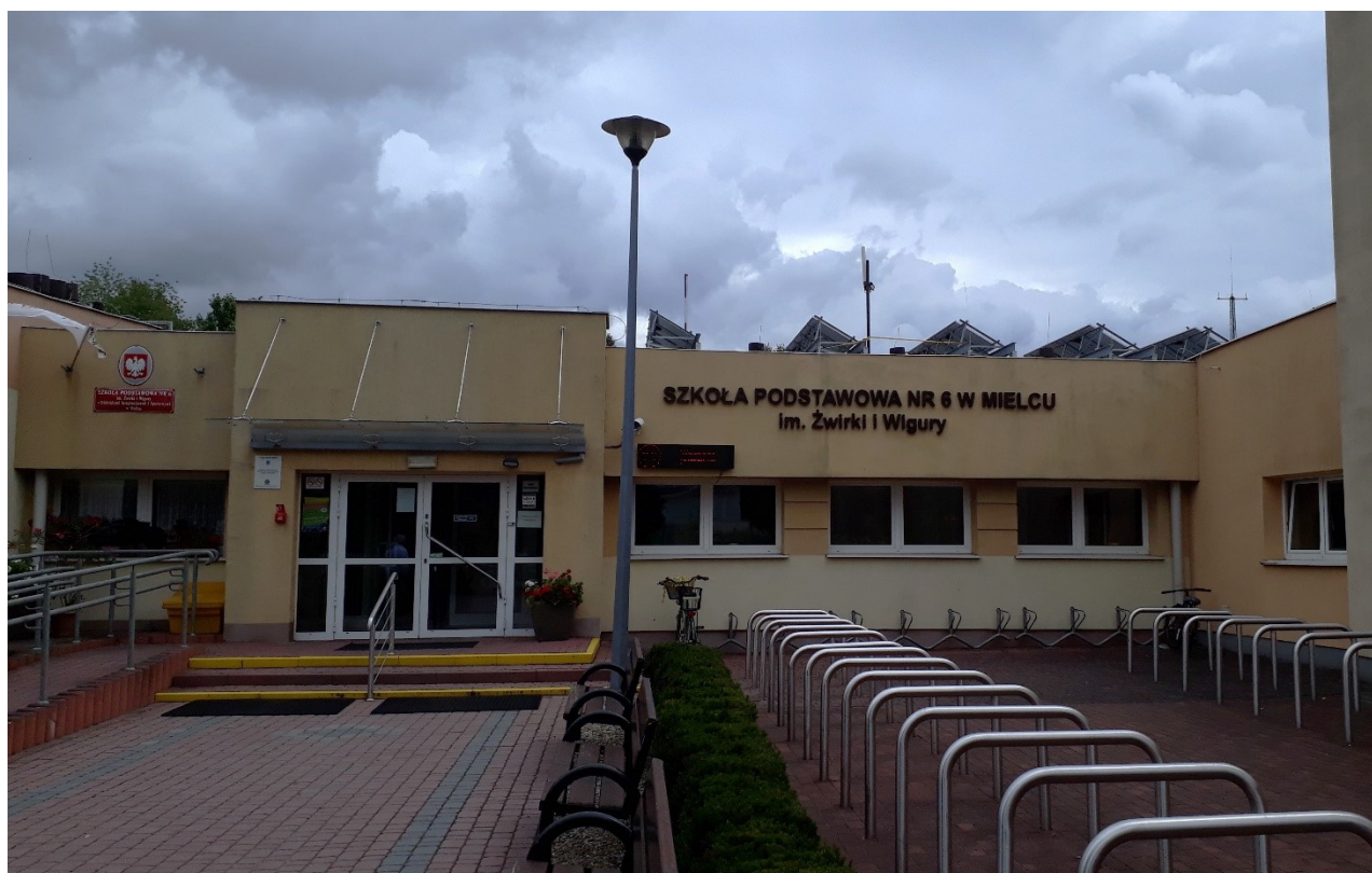
Rys. 2 Miejsce montażu SMS PEM – Szkoła Podstawowa nr 6 w Mielcu – widok z poziomu gruntu
