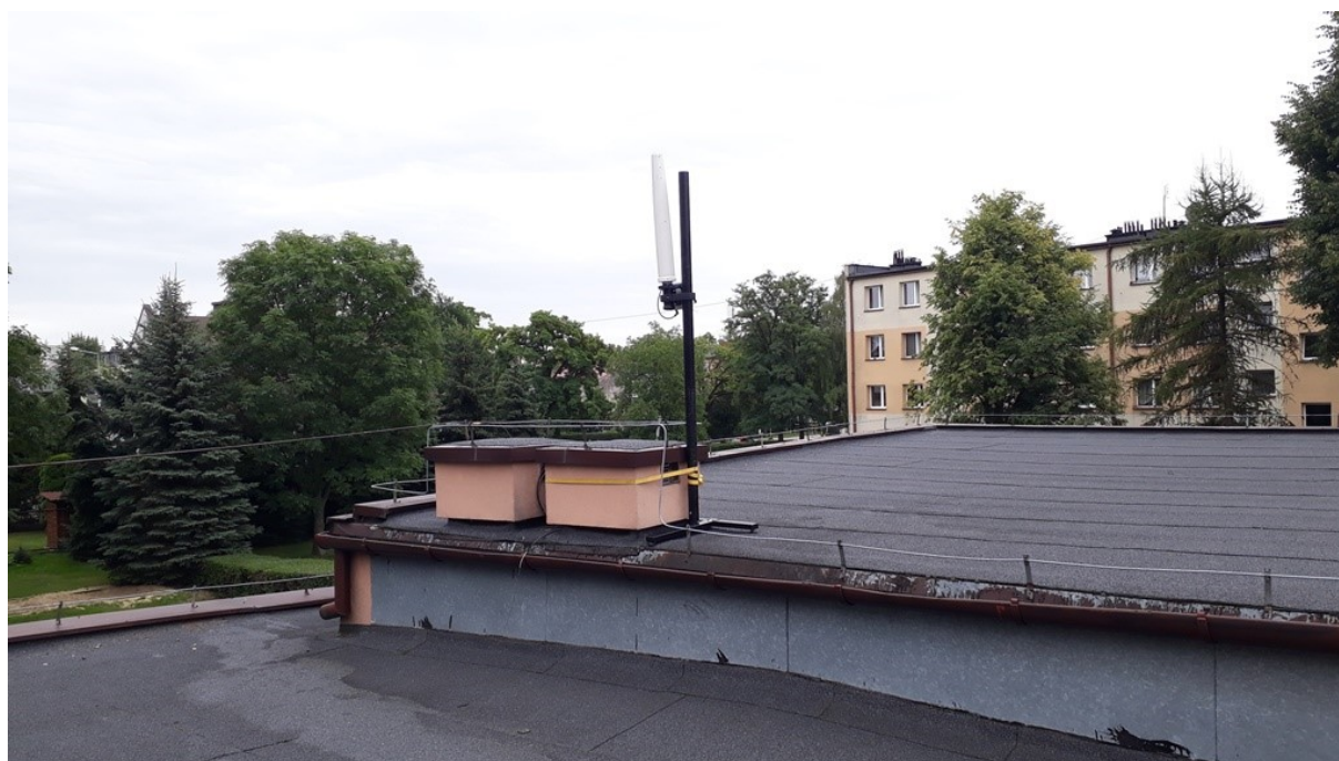
Rys. 2 Miejsce montażu SMS PEM – Przedszkole nr 14 w Tarnowie
