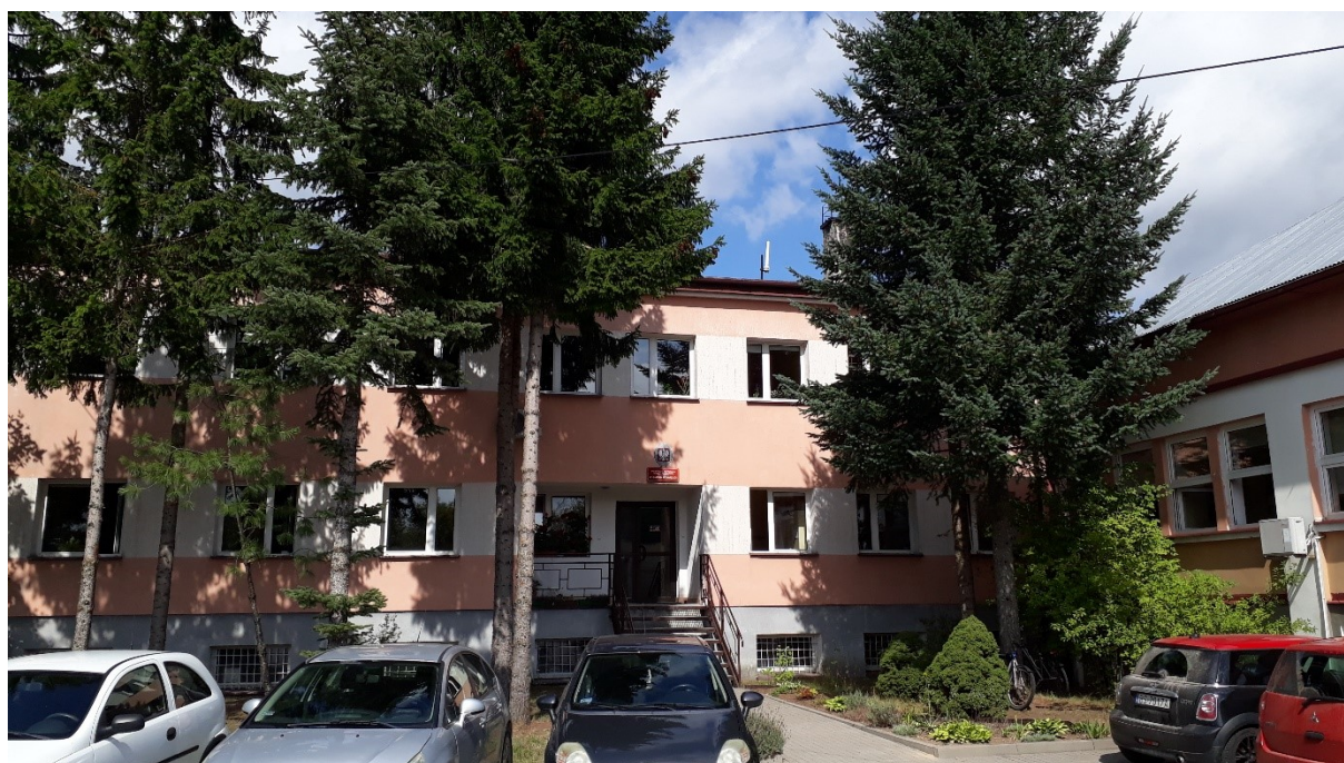
Rys. 2 Miejsce montażu SMS PEM – WIOŚ Delegatura w Suwałkach – widok z poziomego gruntu
