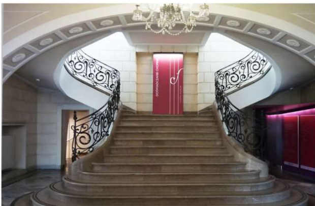
Stopnie schodów znaczone ciemnymi, kontrastującymi taśmami
