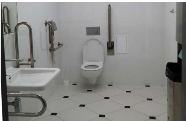
Toalety dla osób z niepełnosprawnościami
