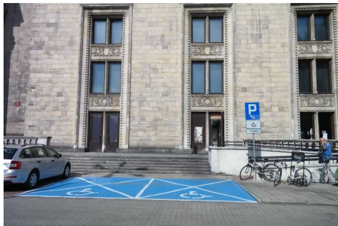
Zdj. 02, 03 Miejsca parkingowe dla osób z niepełnosprawnością w otoczeniu zabytkowego PKiN w Warszawie, nawierzchnia z kostki brukowej
