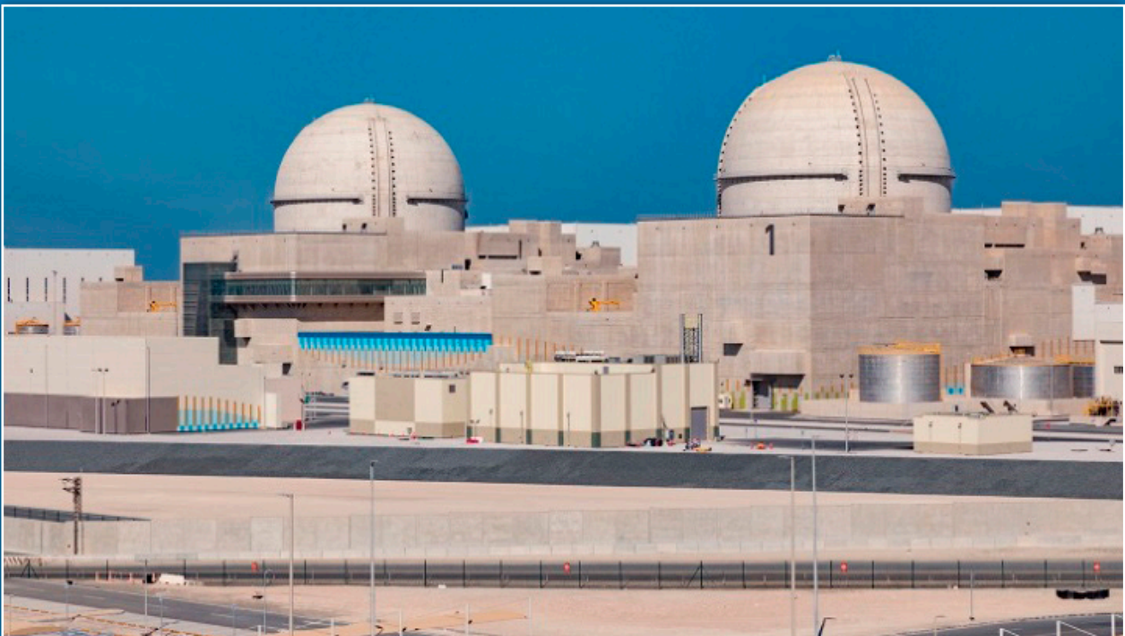
Koreański atom w Zjednoczonych Emiratach Arabskich. Elektrownia Jądrowa Barakah. (fot. Emirates Nuclear Energy Corporation – ENEC)
