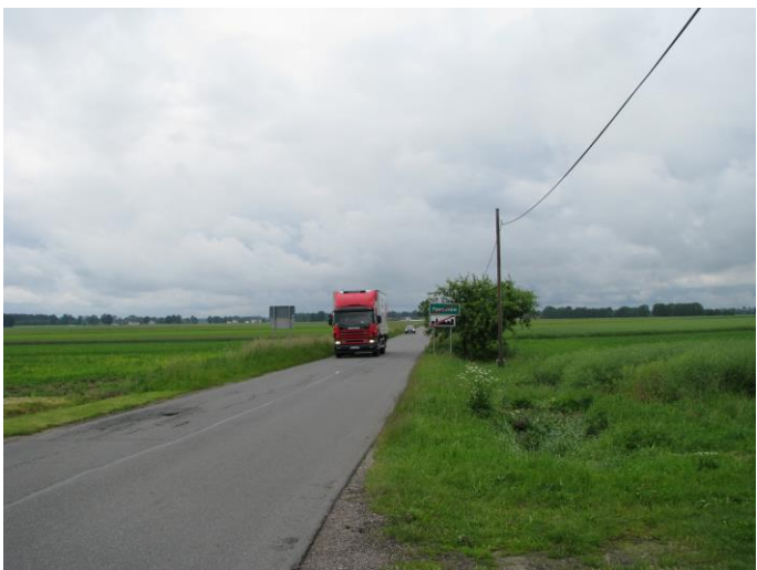
Fot. 2. Pawonków, RB1. Ul. Skrzydłowska widok w kierunku Skrzydłowic
